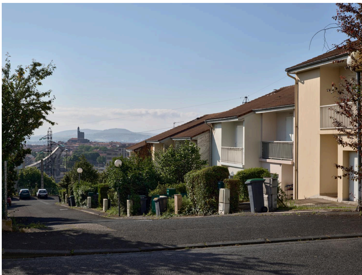
Partie secondaire de la cité sur la rue d'Apollon.
