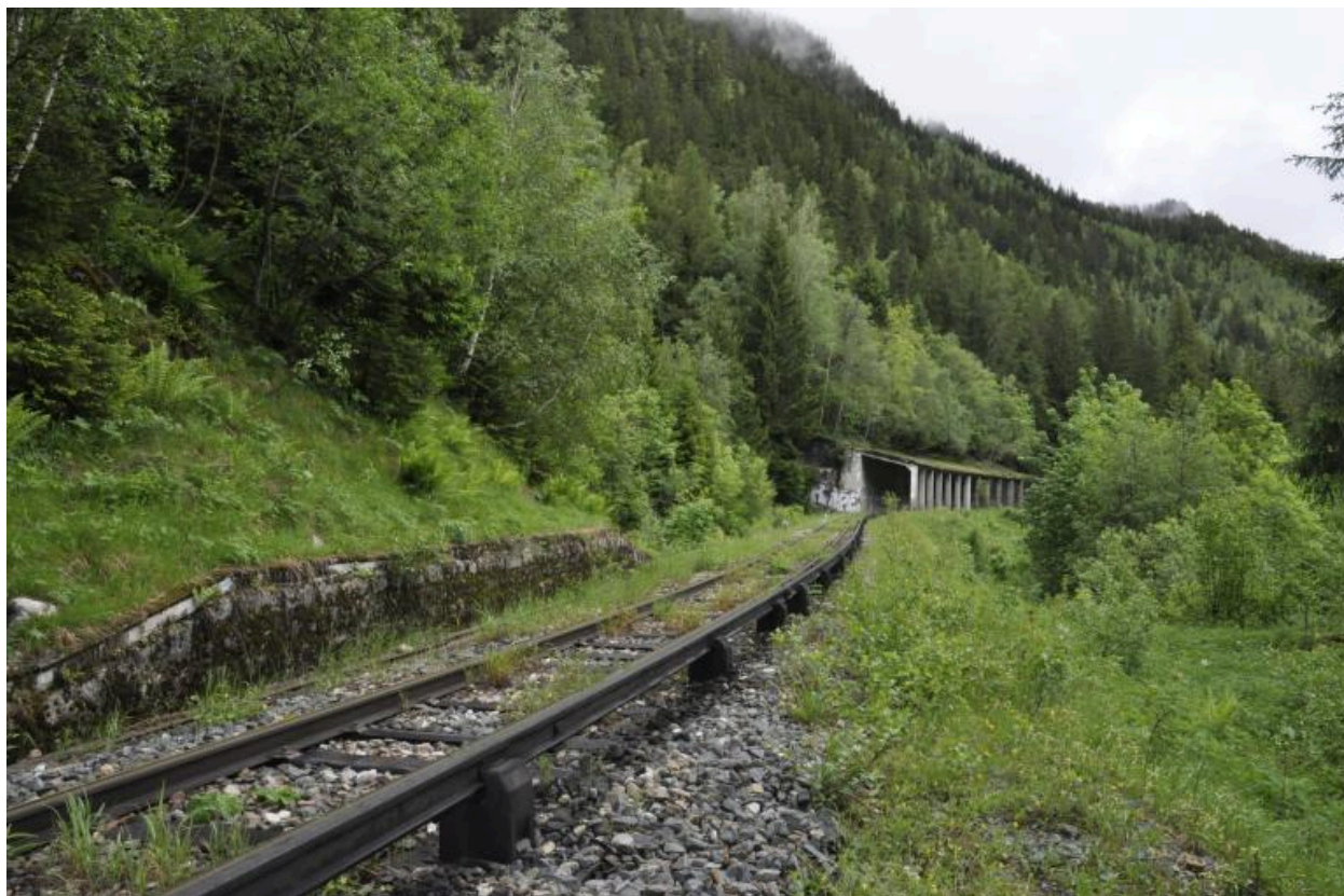
Voie ferroviaire passant sur l'aqueduc allant en direction de la halte des Tines
