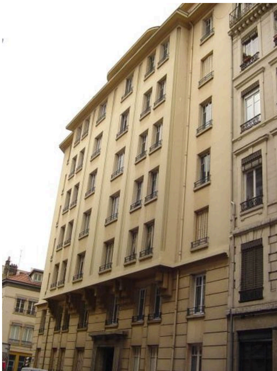
Elévation rue Duguesclin
