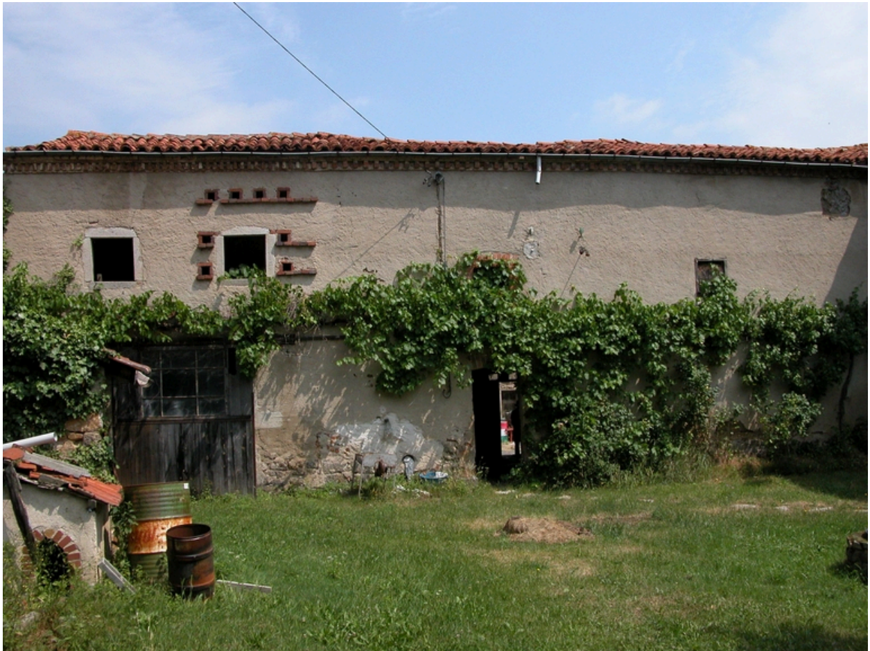
Vue de l'élévation sud du logis du fermier et de la remise-atelier (à l'étage, ouvertures du pigeonnier).
