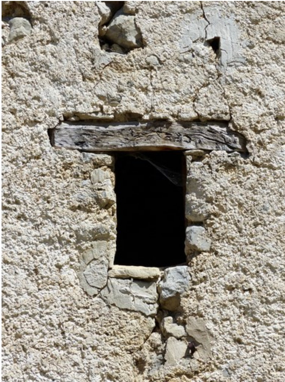
Pignon sud, premier niveau. Jour.
