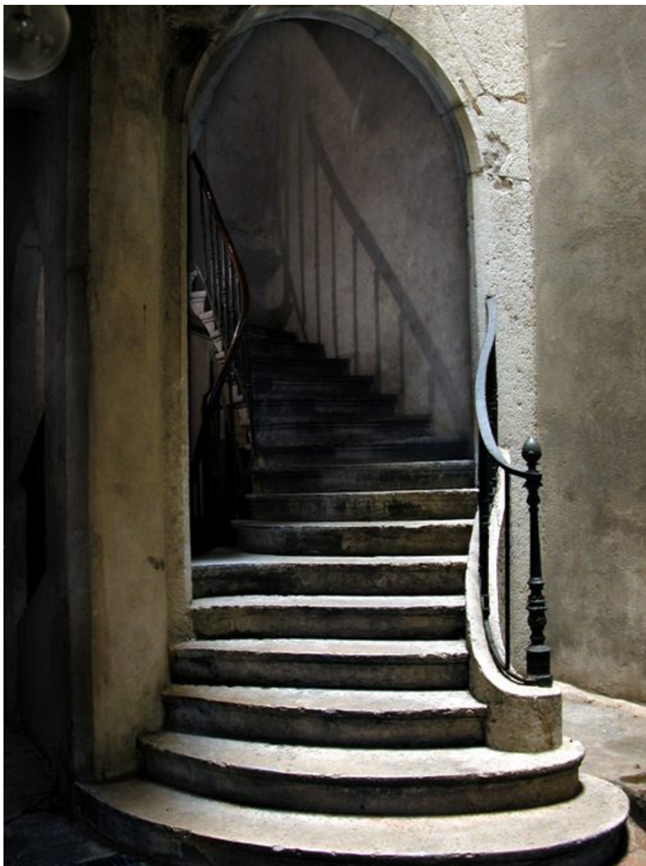
Vue partielle du départ d'escalier
