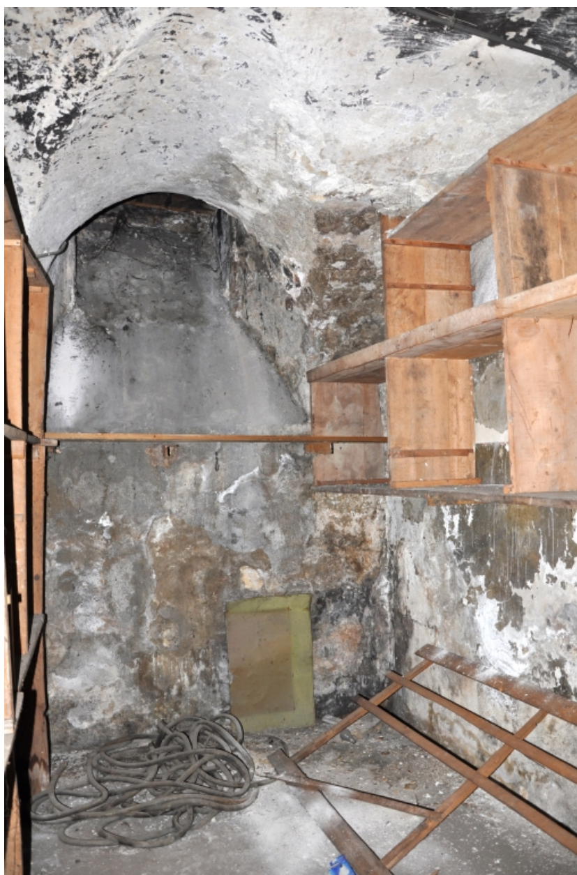
Sous-sol du corps principal : voûte
