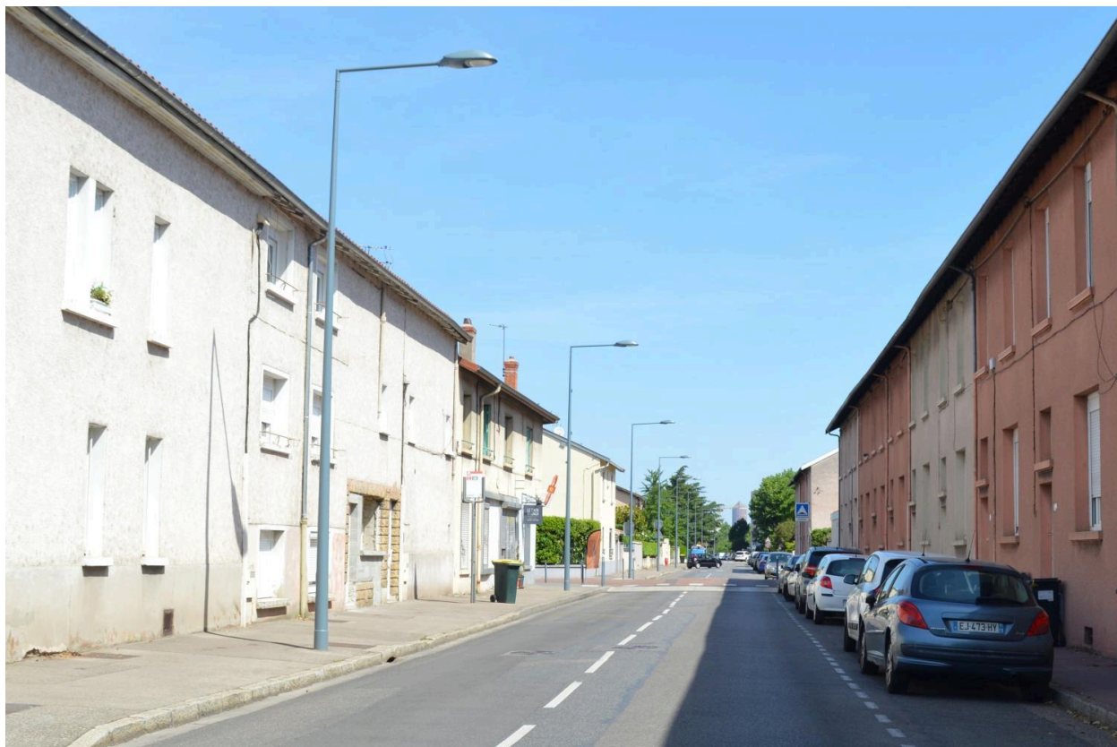
Cité ouvrière de l'usine de Tubize vers 1924 - Rue du Professeur Roux
