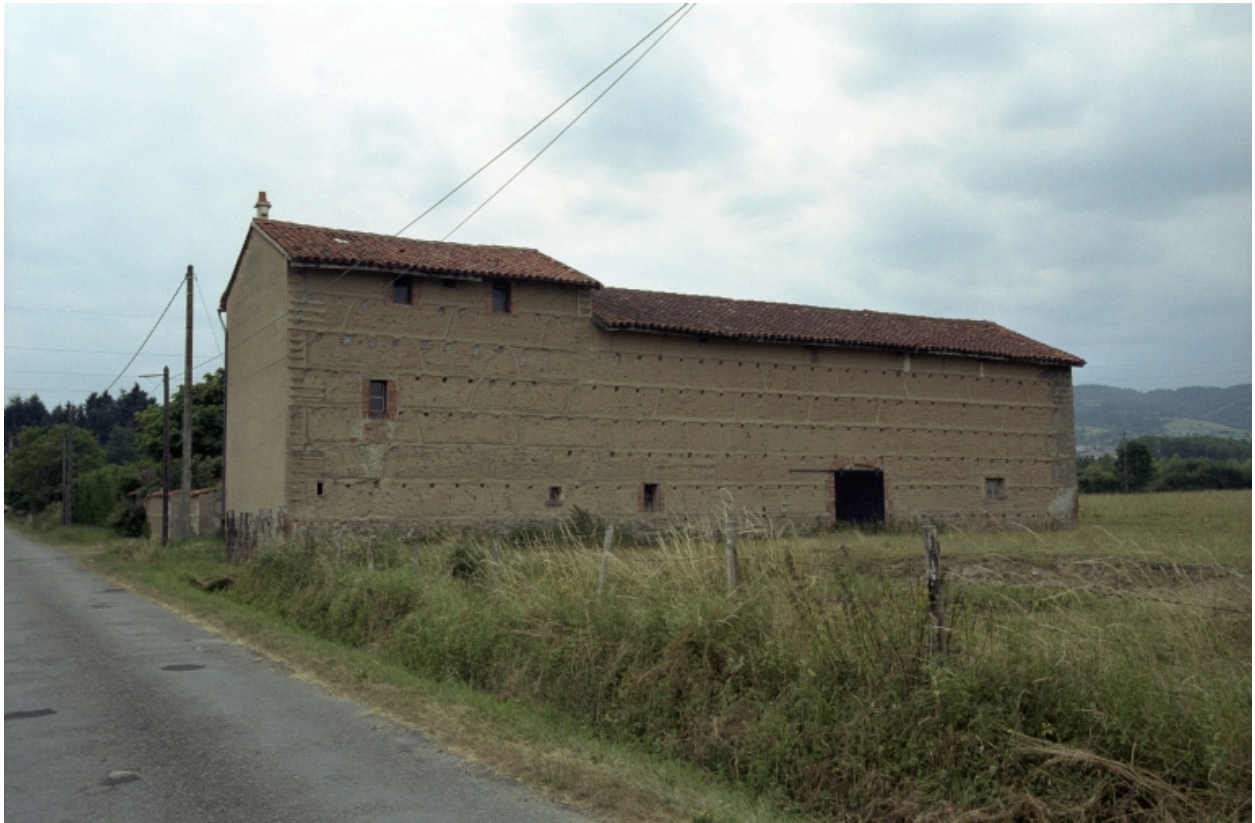
Montverdun, Chantepedrix (1986 ZA 83 à 85), type A1. Façade postérieure de la grange-étable.
