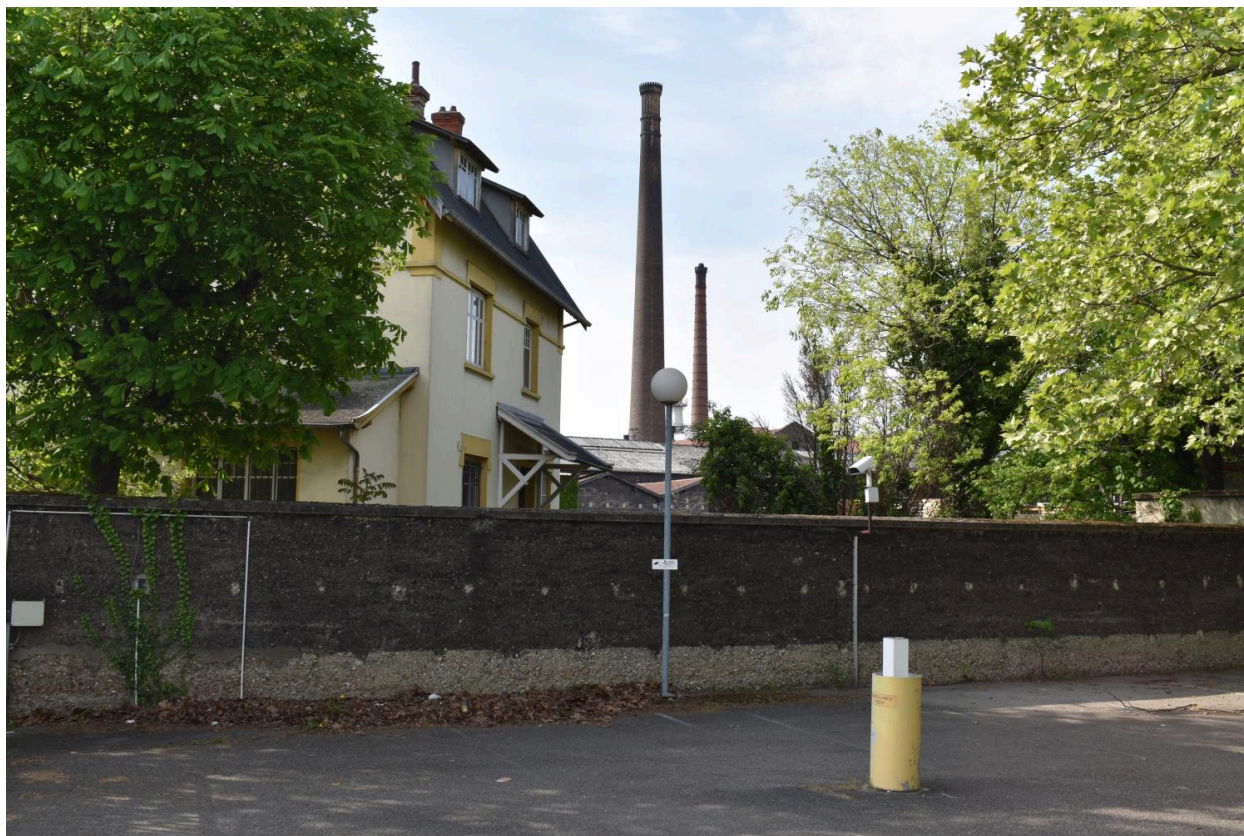
Saint-Gobain - Savoie Réfractaires - percée visuelle sur la cheminée - vue depuis la rue de l'Industrie
