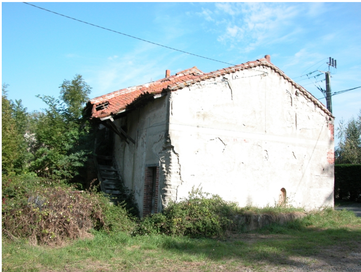
Vue d'ensemble du logis depuis le nord-ouest.
