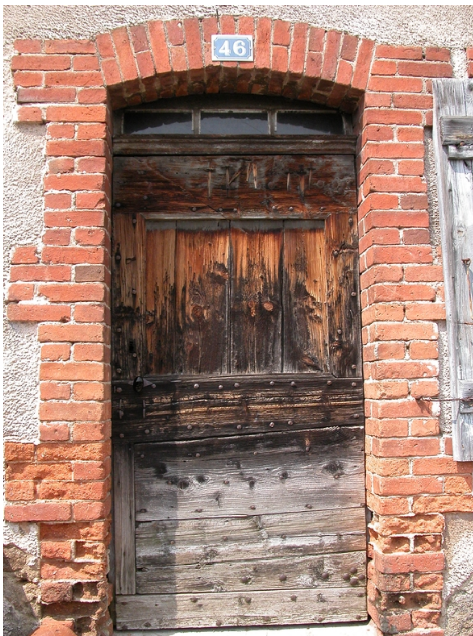
Le Bourg, rue de l'Hospice/chemin des Efossés. Maisons, ferme (1999 AD 171). Détail des façades sur le chemin des Efossés : porte (croisettes clouées sur le vantail).
