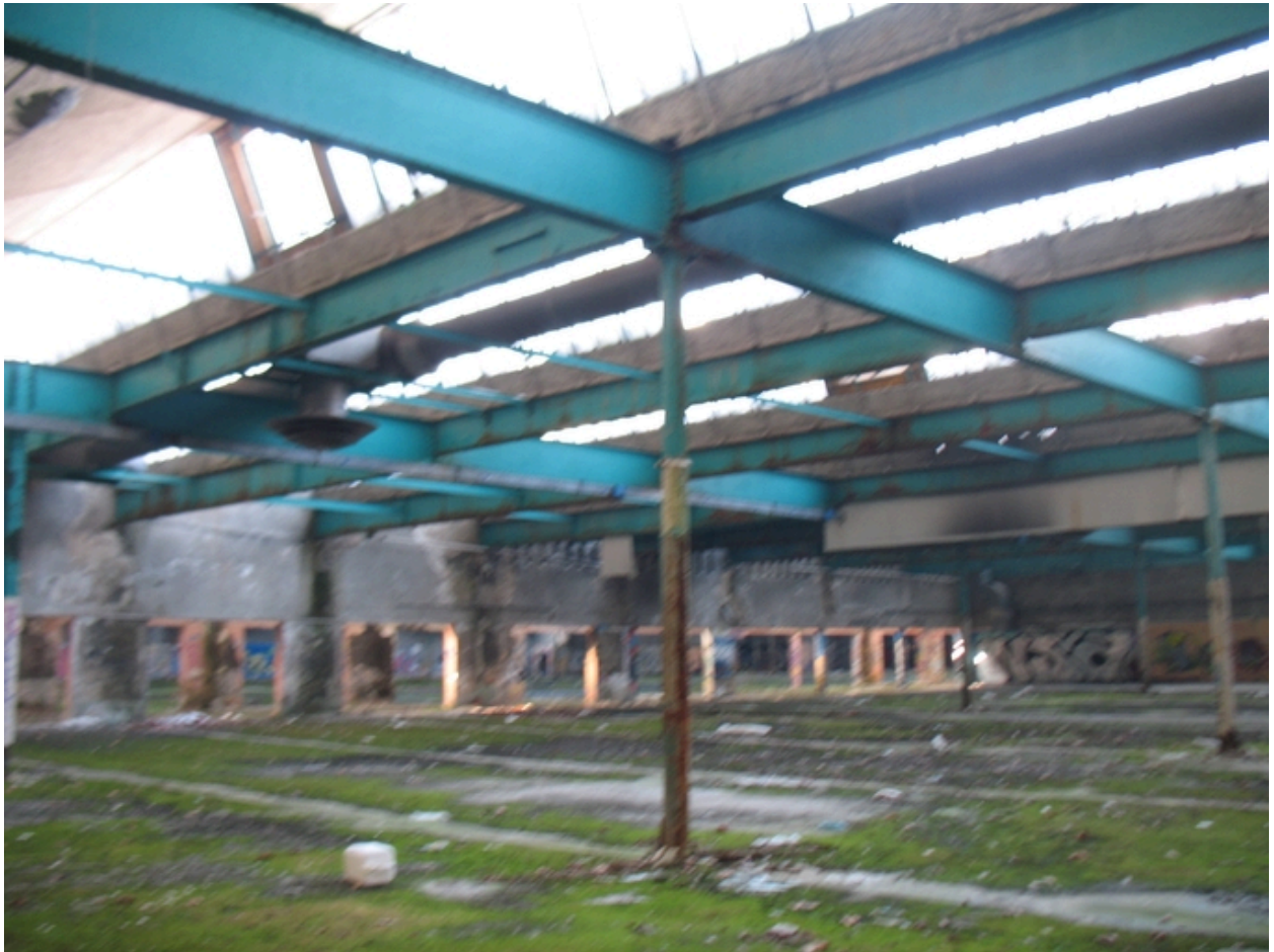
structure charpente métallique et piliers des ateliers en rez-de-chaussée
