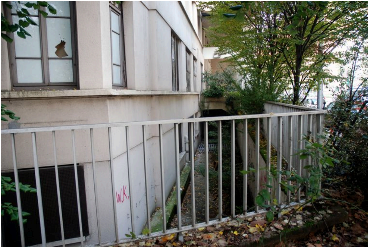
Détail du sous-sol et du premier étage.
