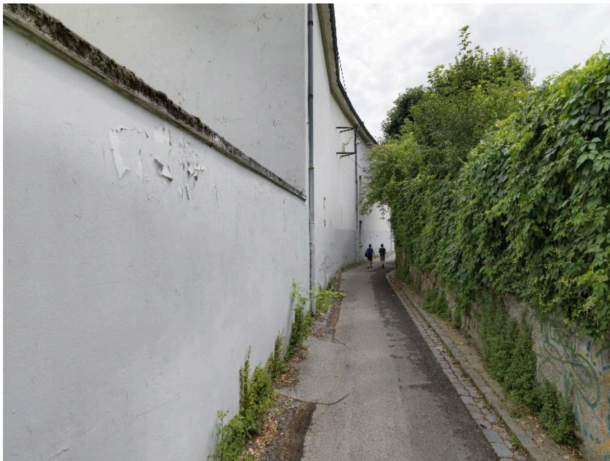
Vue arrière des bâtiments, depuis le chemin de Montauban
