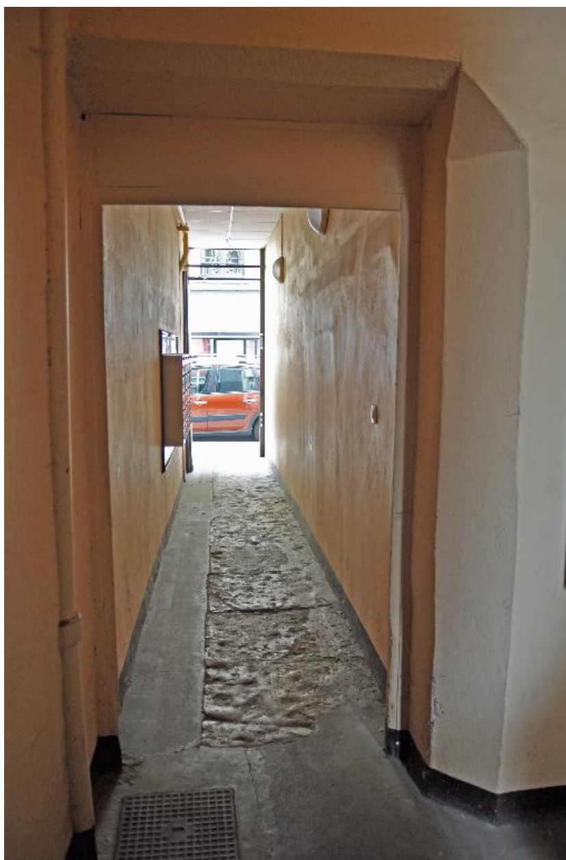
Vue de l'allée, depuis l'escalier
