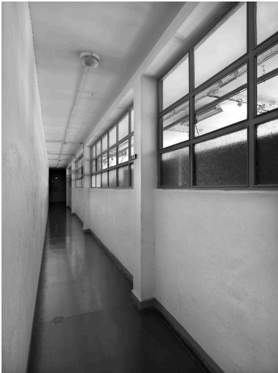
Bâtiment E, 1er étage, Couloir, vue depuis l'ouest
