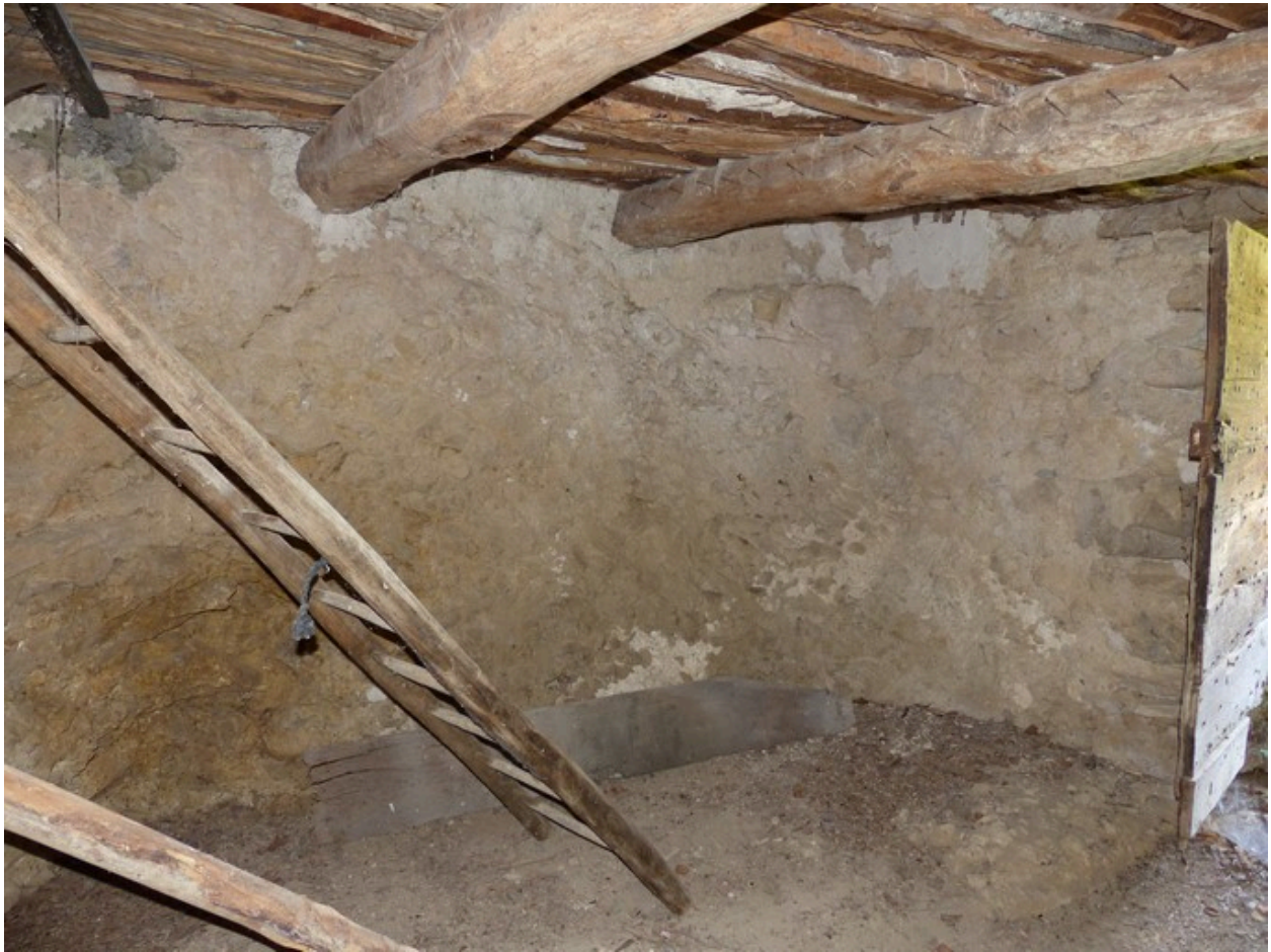
Premier étage de soubassement, resserre. Vue de volume prise du nord-ouest.
