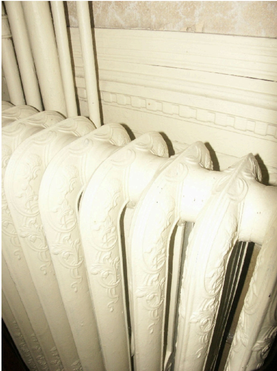
Ancien salon : détail d'un radiateur
