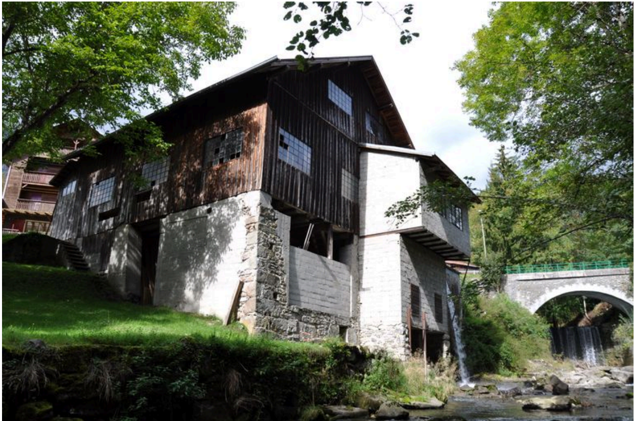
Élévation sud-est du bâtiment de la scierie
