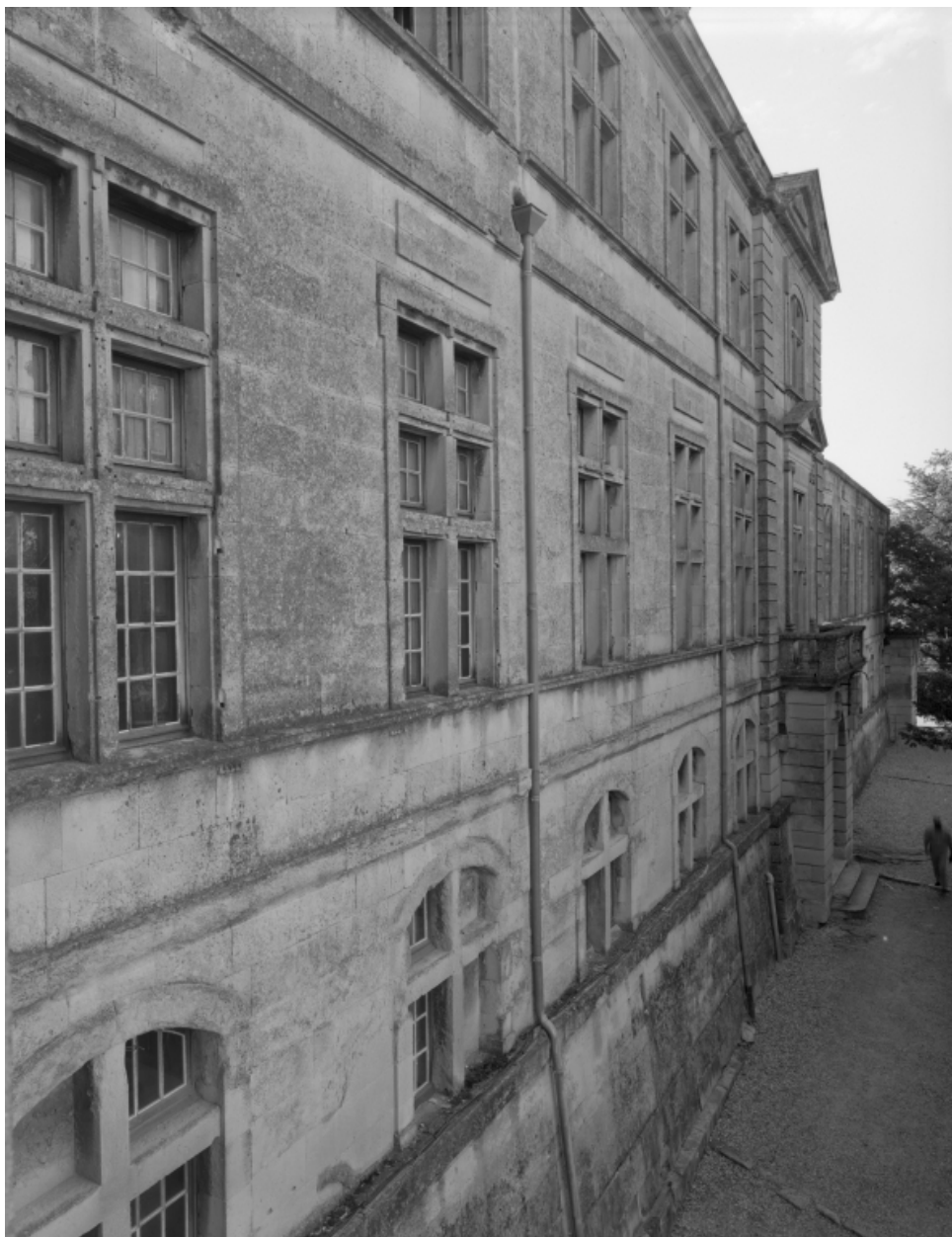
Aile dite des prélats. Vue générale prise depuis le grand cabinet de Madame.
