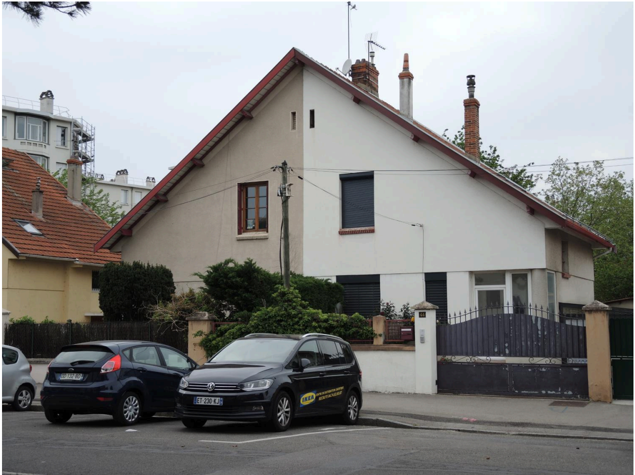
Façade sud d'une maison-double
