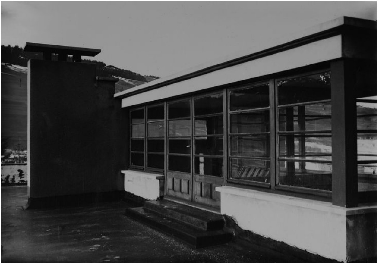
Le roof sur le toit terrasse. Photogr. Tops Socquet, Megève, [milieu XXe siècle] (AD Haute-Savoie. 142J 575)
