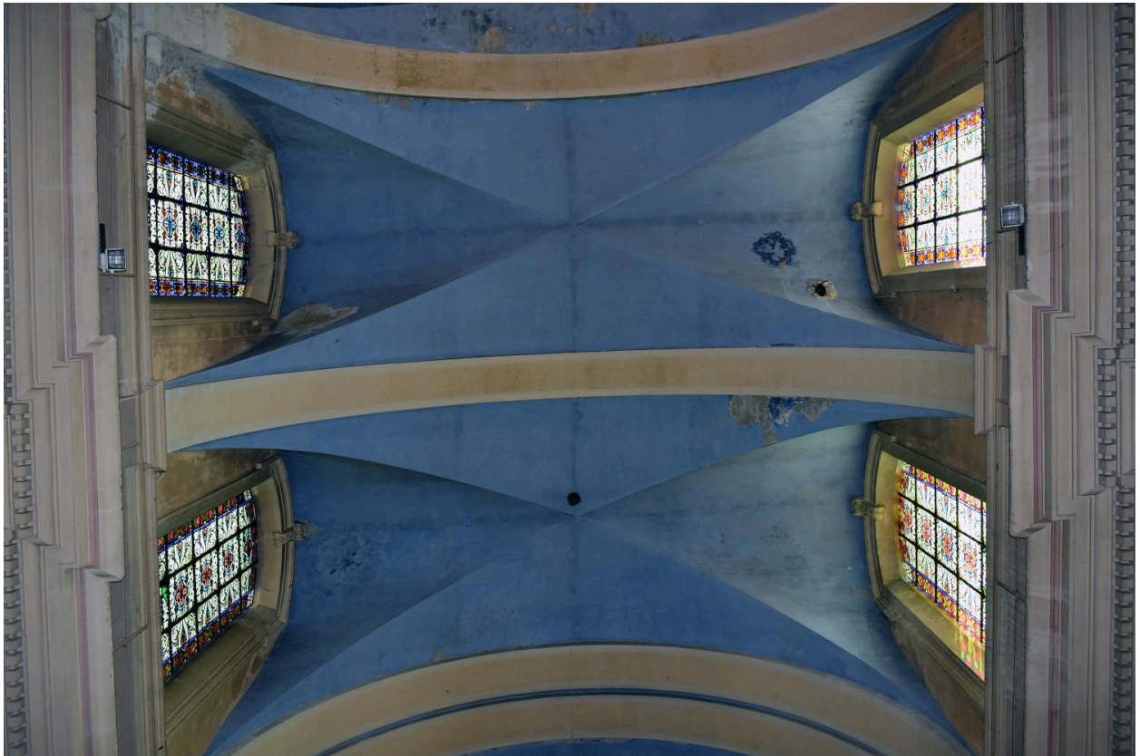
Nef : détail de la voûte
