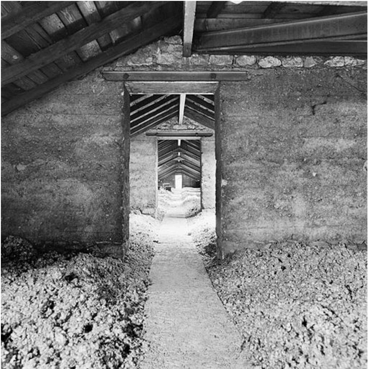
Charpente métallique des combles du corps de bâtiment de l'école maternelle, rue Saint-Michel
