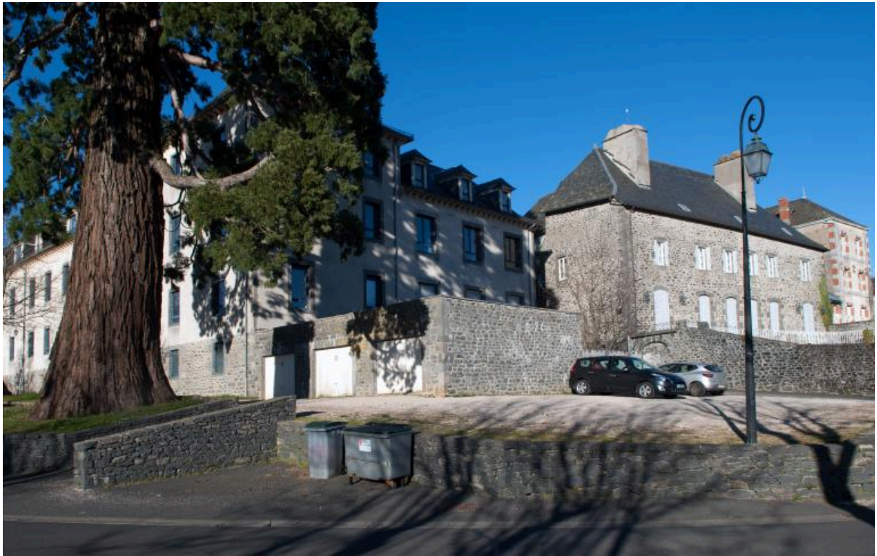
Vue d'ensemble depuis le sud-ouest : élévation latérale sud
