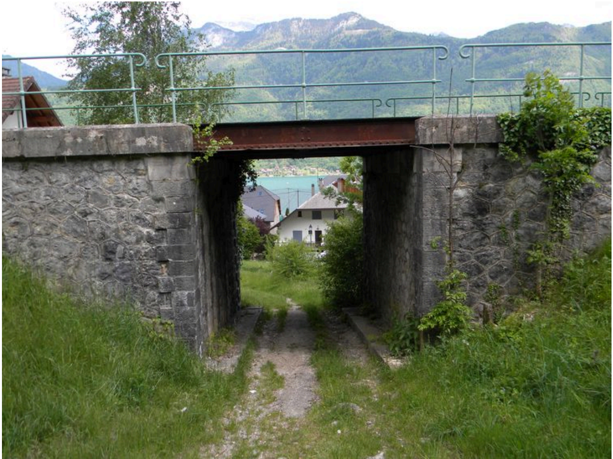
Vue générale du pont avec le village de Bredannaz en arrière-plan.
