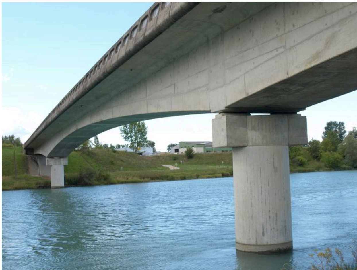
Arche, face amont (depuis la rive droite)
