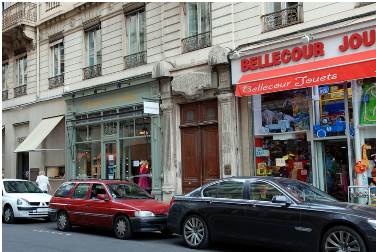
Elévation rue Gasparin : le rez-de-chaussée
