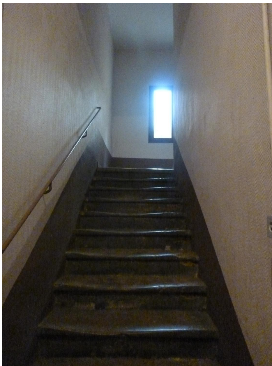
Escalier à mur noyau plein
