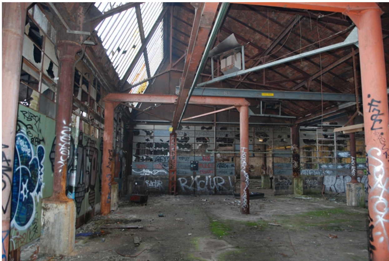
Vue d'ensemble de l'atelier
