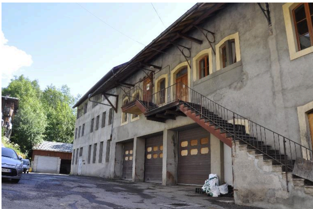
Vue des escaliers donnant sur la coursive de la façade antérieure du bâtiment de l'usine
