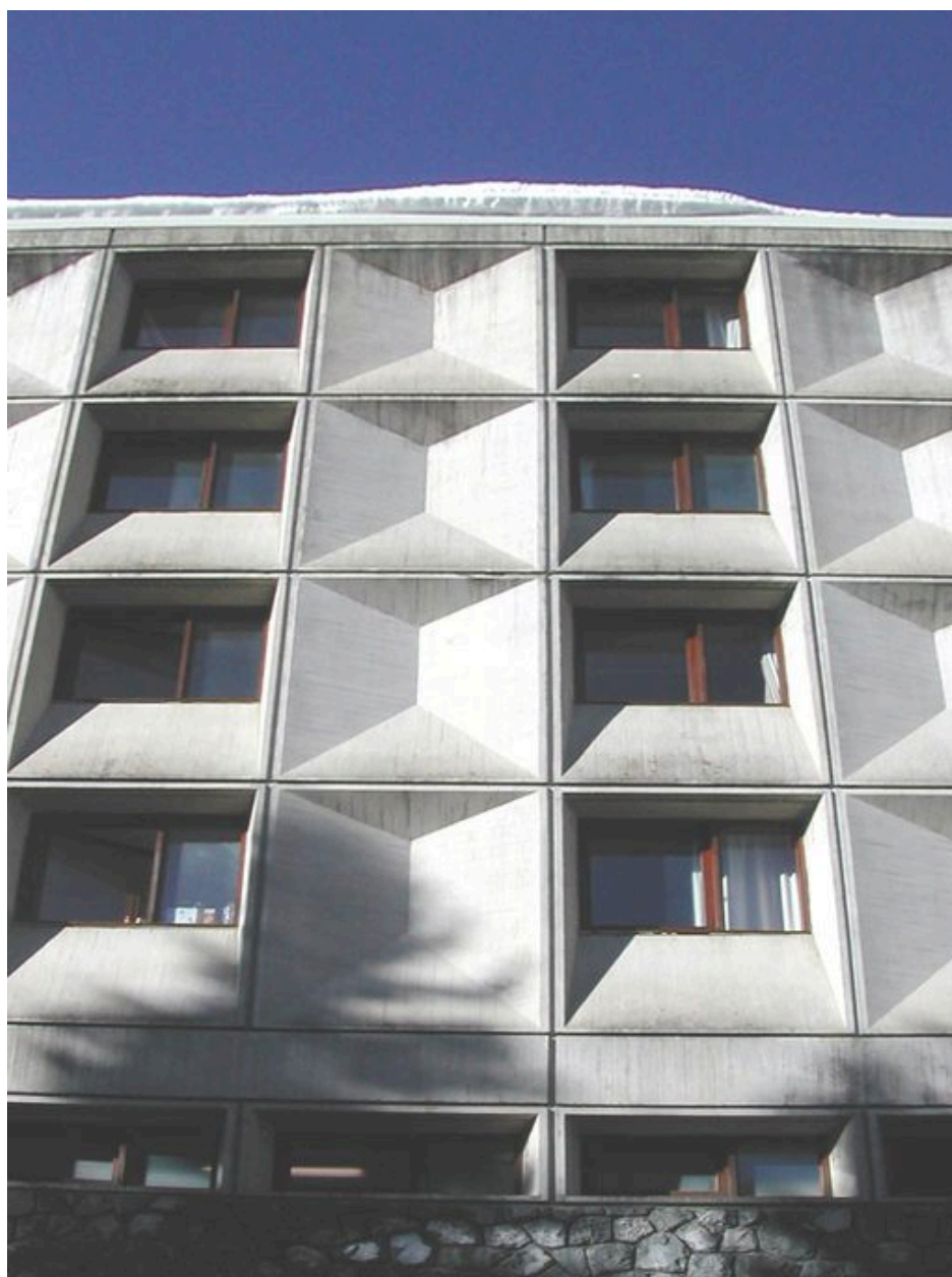
Façade principale. Détail des baies et des panneaux de béton préfabriqués
