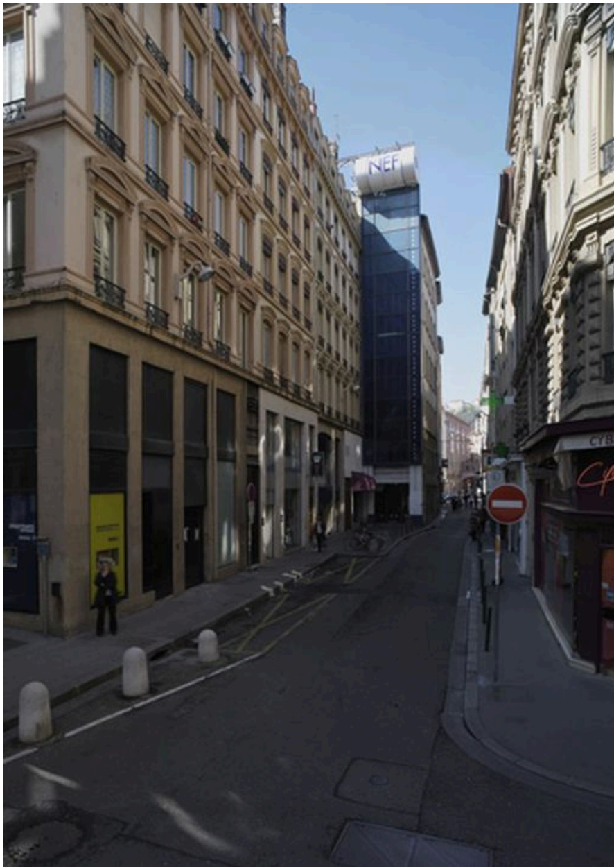
Vue depuis l'est (rue de la République)
