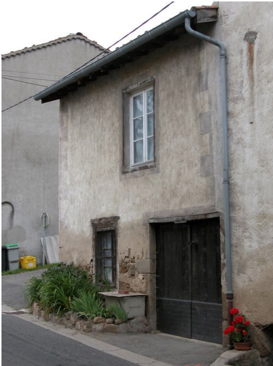
Vue d'ensemble de la partie gauche de la construction.
