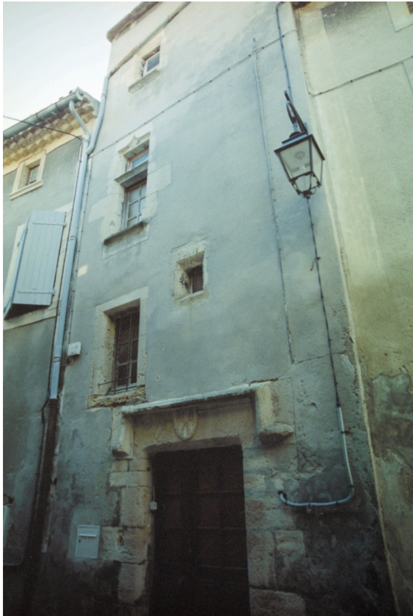
Rue d'Or. Maison (ancien hôpital) de type I, à une travée et porte latérale (D2 216).
