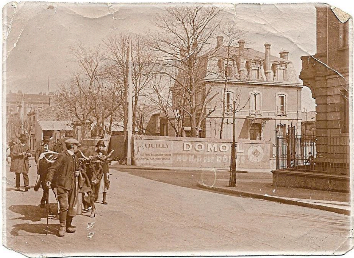
angle de l'avenue d'Italie et de l'avenue Charras (entre 1928 et 1935)
