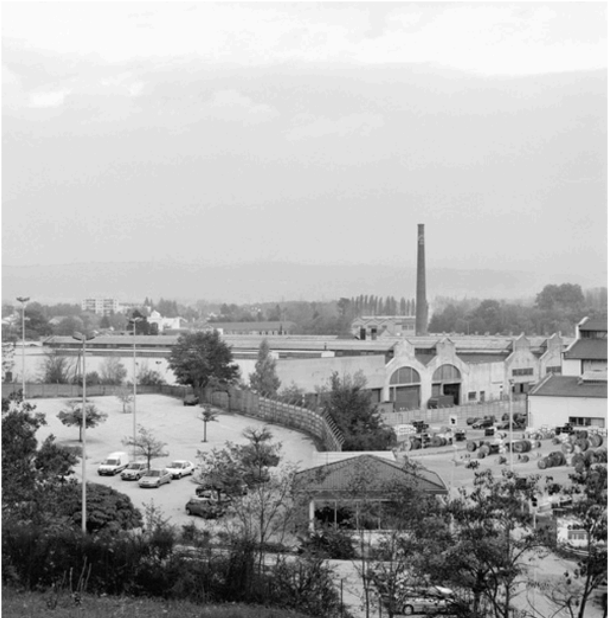
Vue d'ensemble avec cheminées
