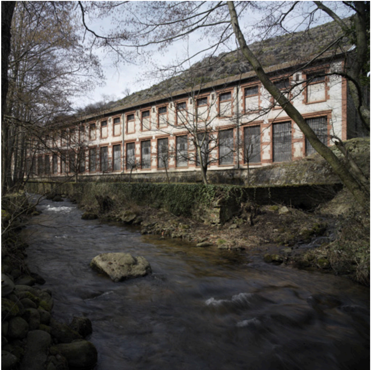
Vue des ateliers, depuis le sud-est.
