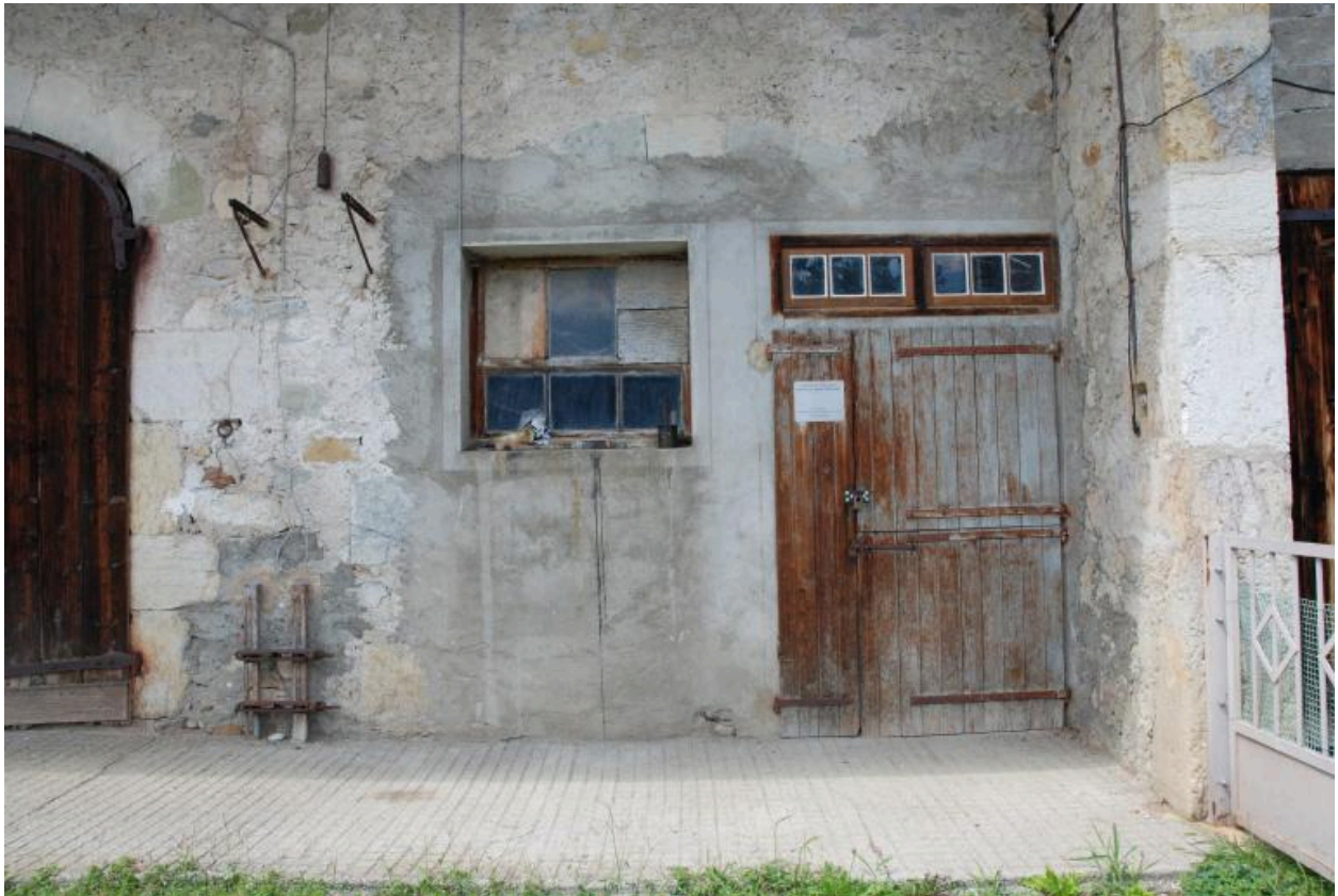
Détail des ouvertures de la grange-étable (vestige de la porte d'étable en arc).
