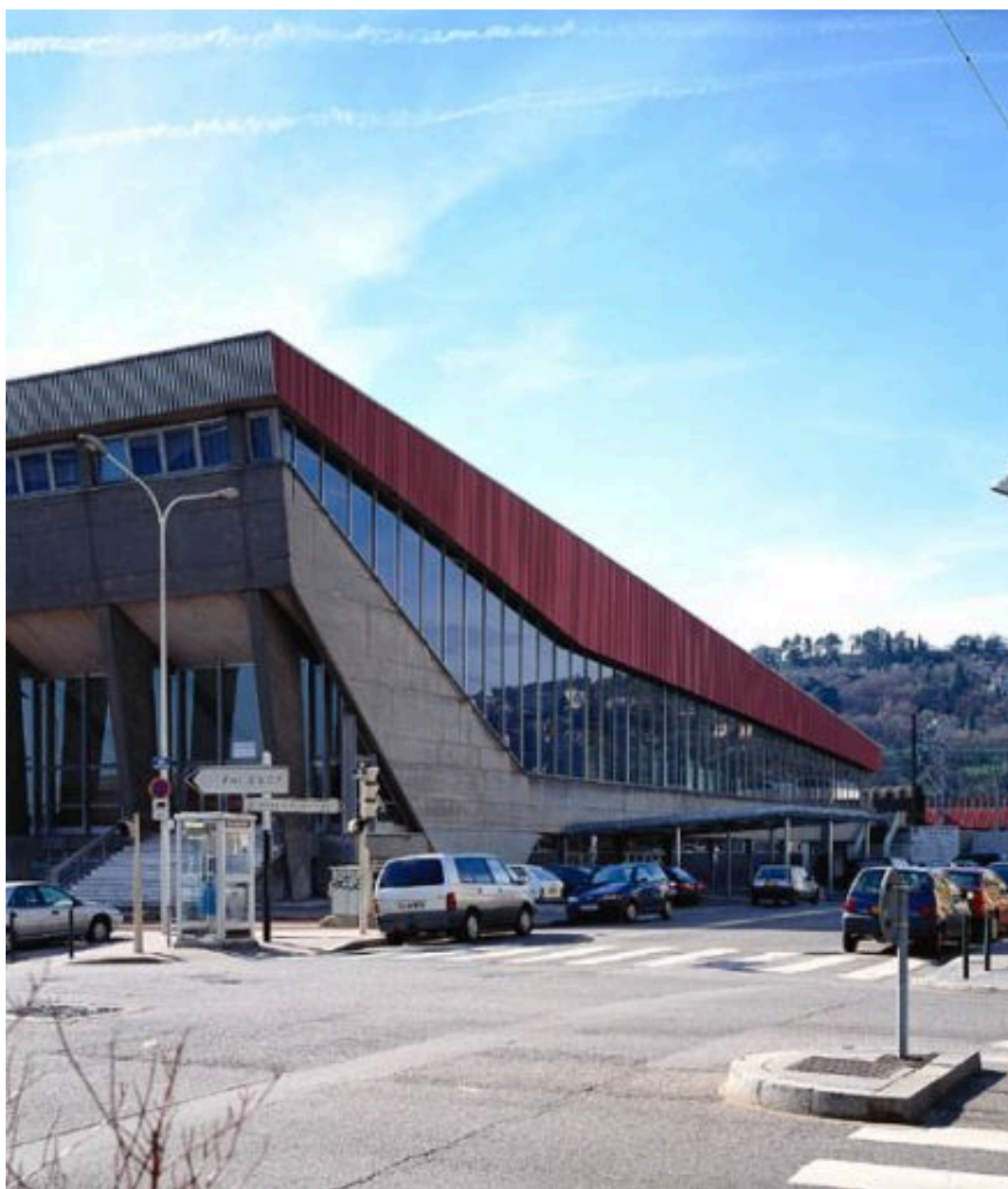
Vue générale de la façade nord
