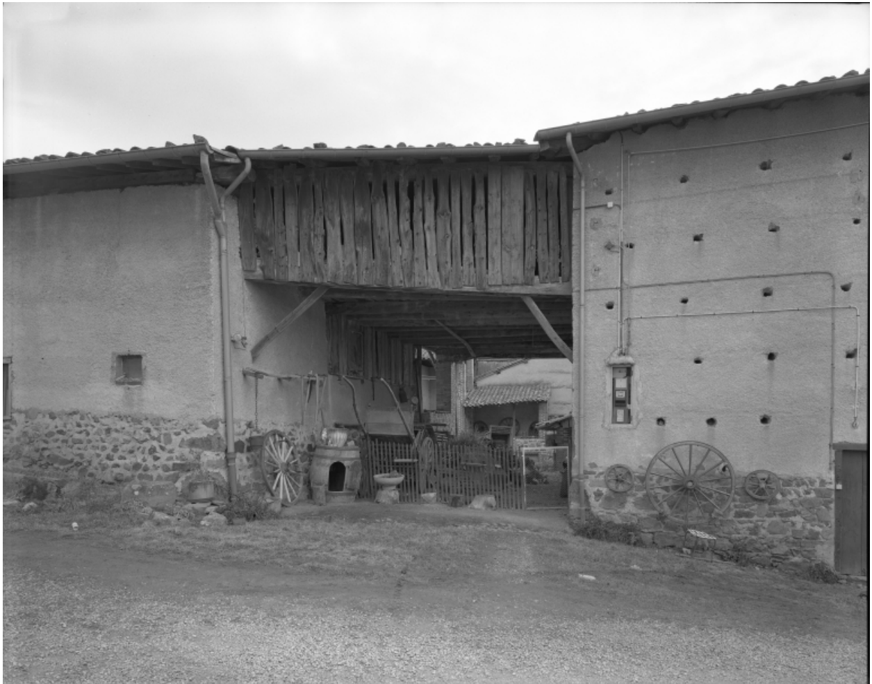
Vue du passage couvert entre les deux cours.
