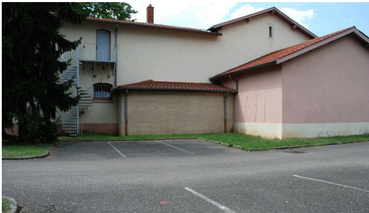
Ancienne boulangerie, façade postérieure (est), restes du four
