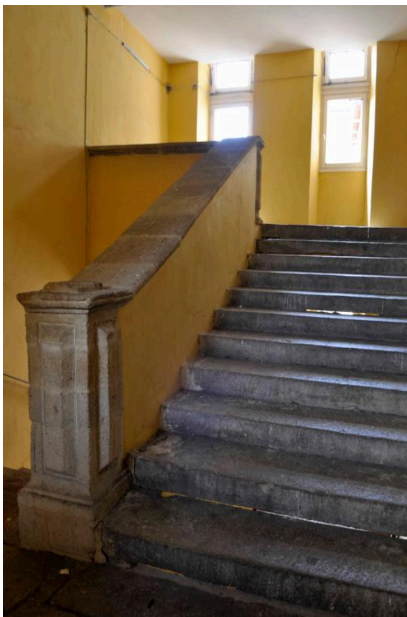
Bâtiment F : escalier, dernière volée
