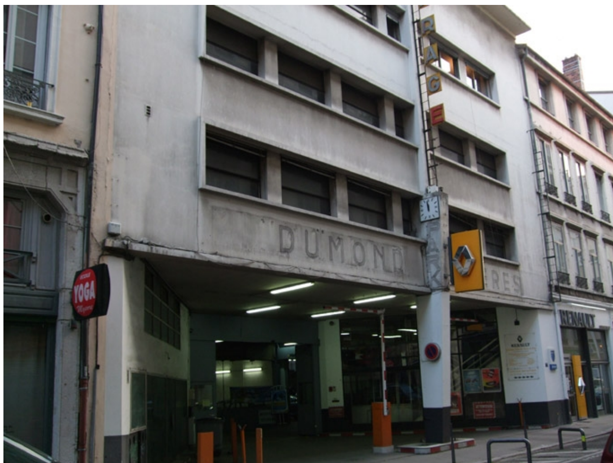
Façade du 7, rue Duhamel avec ancienne enseigne Dumont
