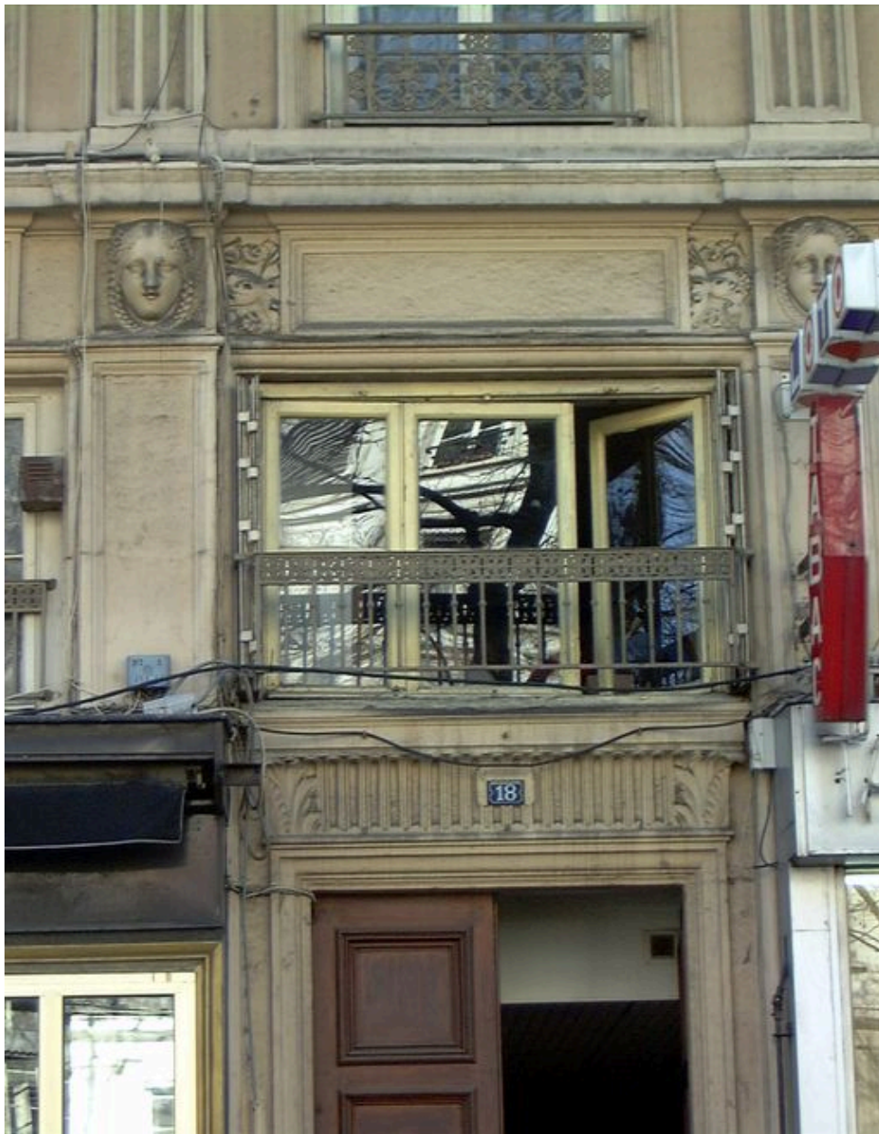
Façade sur le cours Franklin-Roosevelt, détail de la fenêtre de l'entresol au-dessus de la porte
