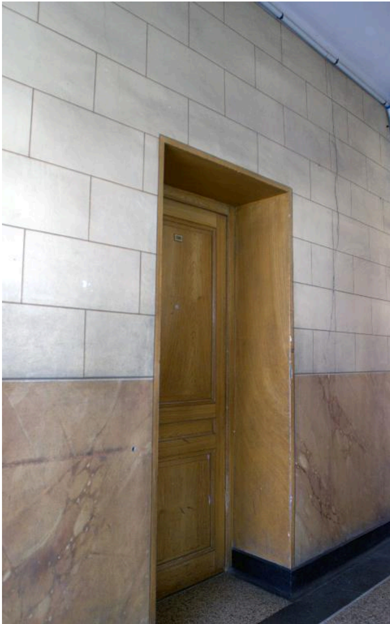
Bâtiment C porte, couloir du 1er étage
