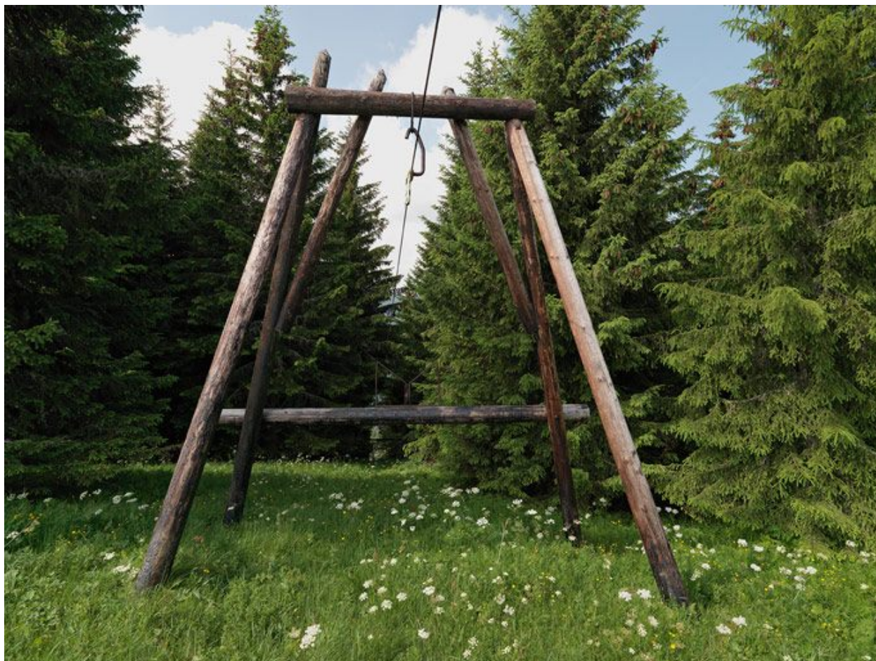
Rochebrune. Câble à lait et/ou à bois. Un pylône
