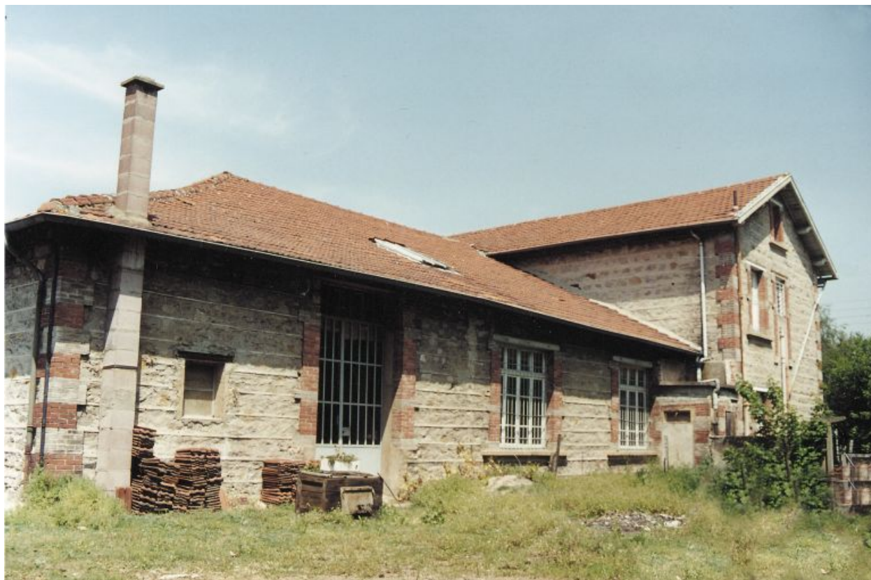
Vue d'ensemble extérieure de trois-quarts des ateliers. AP S. Chalencon
