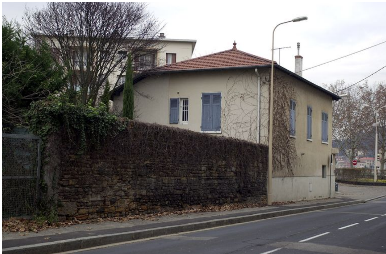
Vue générale depuis la rue Joannès-Carret
